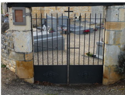
Souillaguet : remplacement du portail.
