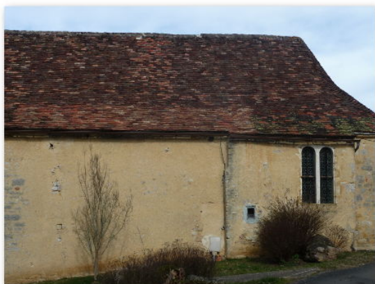
Église de Souillaguet : réfection de la toiture côté route.
